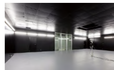
第1気流試験施設 複数の制気口による気流干渉や、ペリメーター負荷変動による温熱環境の測定が可能です。
