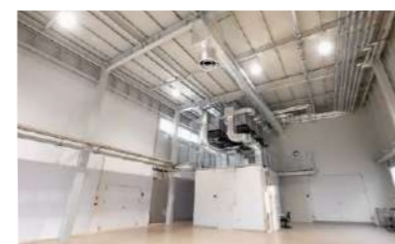
第2気流試験施設 高天井・高壁取付器具の到達性能を測定します。
