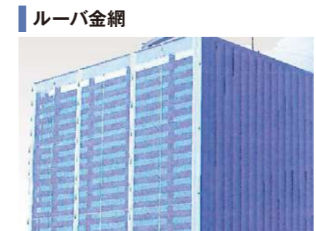
ルーバ金網 冷却塔本来の性能を維持させるために、鳥の巣や虫、飛来物から充てん材を守ります。
