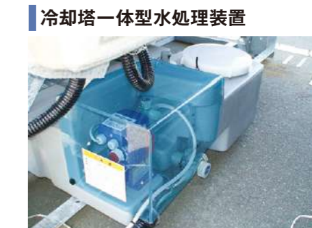
冷却塔一体型水処理装置 循環水にスライム・スケール・腐食を防止し、レジオネラ菌対策ができる薬品を自動的に注入することで、理想的な水処理が可能となります。
