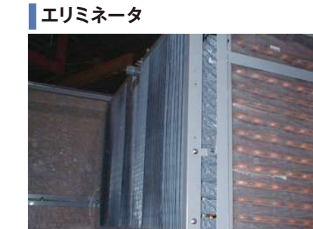
エリミネータ ファンによるキャリーオーバー防止のため塔内にエリミネータを設置することができます。風量を不足させないよう、状況に合わせて設計します。
