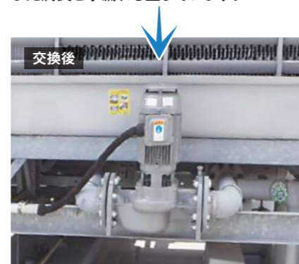
交換後 ベアリング、パッキンの交換、分解整備を行います。劣化が酷い場合は新品と交換します。
